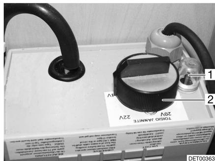
Bild 69 Regler für elektrische Fußbodenheizung
