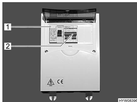
Bild 62 230-V-Sicherungskasten mit Leitungsschutzschalter und FI-Schalter
